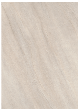
Pogled celotne plošče
